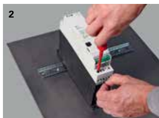
2 Conectar los contactos principales.
