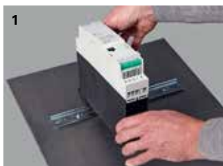
1 Colocar el arrancador de velocidad variable en el carril DIN.
